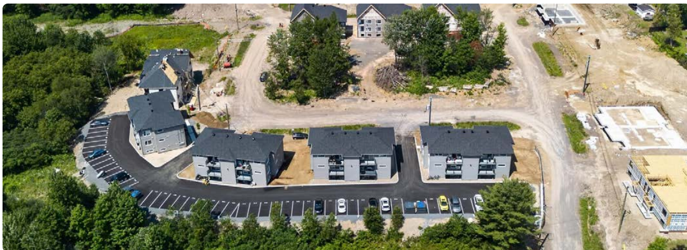
La phase D — rue de la Scierie — et la suite du Quartier Woodbine en construction · photo aérienne, été 2026
